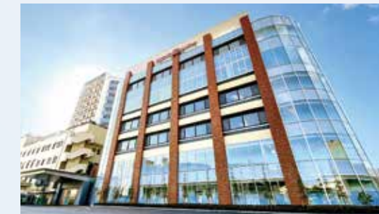
救命救急センター・ 外傷センター棟
